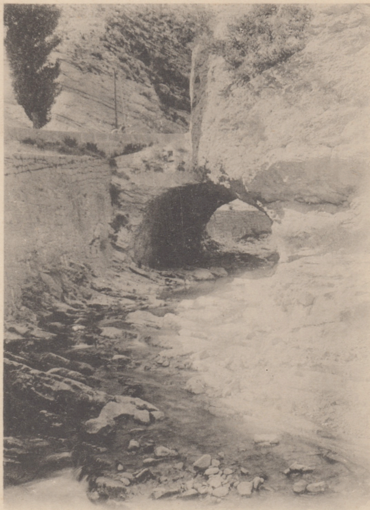
34 SERRES (Htes-Alpes) Gorges de Montclus. Le tunnel
